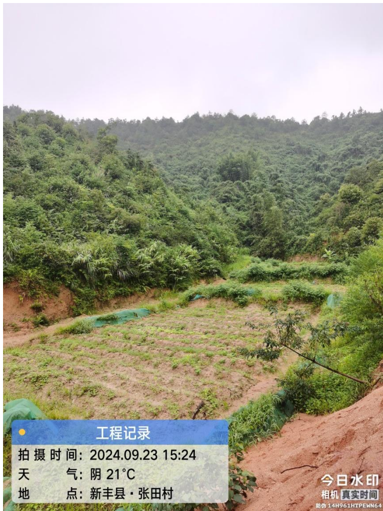
图 5 JG15 竣工照片
