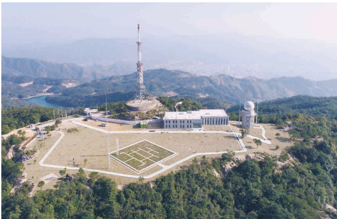
▲ 在建中的新丰国家大气本底站（航拍）
