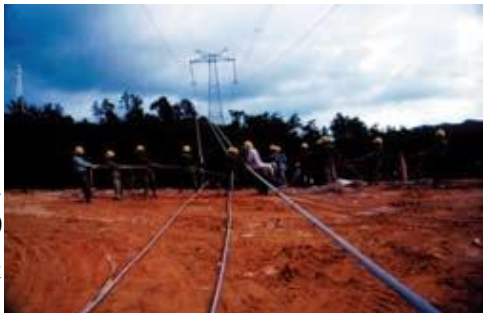
图7-8 途经新丰县的西电东送建设工程
