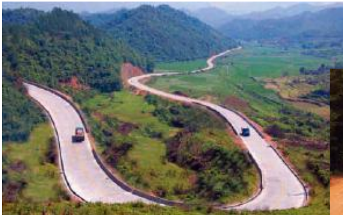
县道347线环山公路
