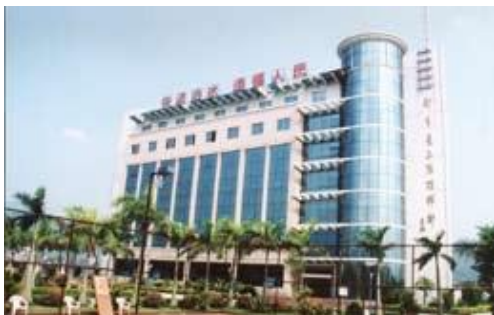
图7-1 县水利局新办公楼
