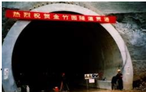
图6-6 2001年竣工的省道347线金竹园隧道
