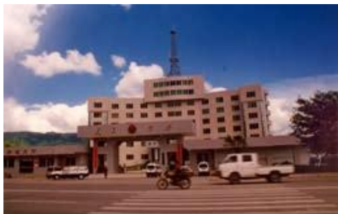
图25-1 新丰县公安局办公大楼
