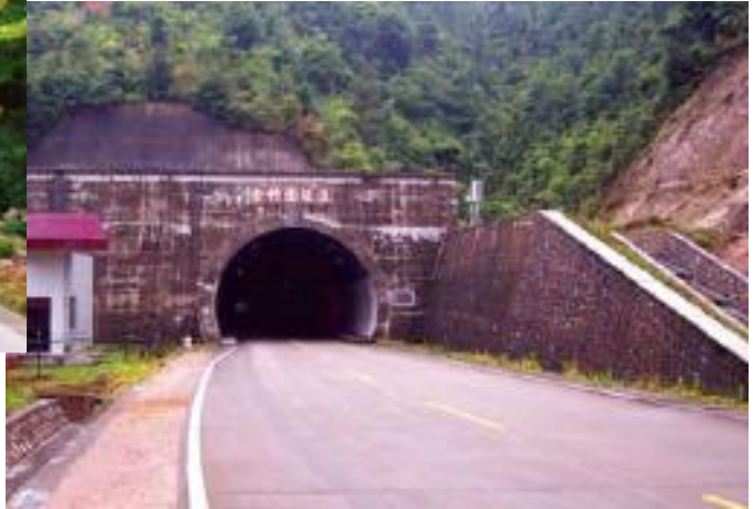
新丰金竹园隧道
