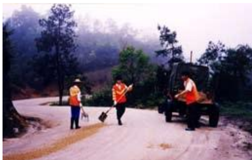
图6-7 1999年，县道班工人正在养护公路
