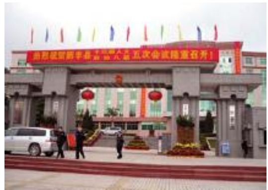
新丰县委、县政府办公大楼正门
