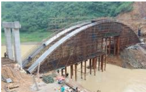
图6-5 2005年在建中的新丰江大桥
