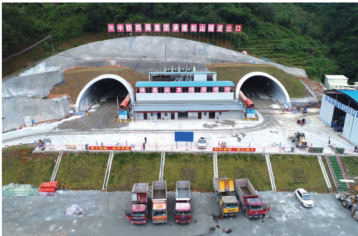
韶新高速松山隧道施工现场
