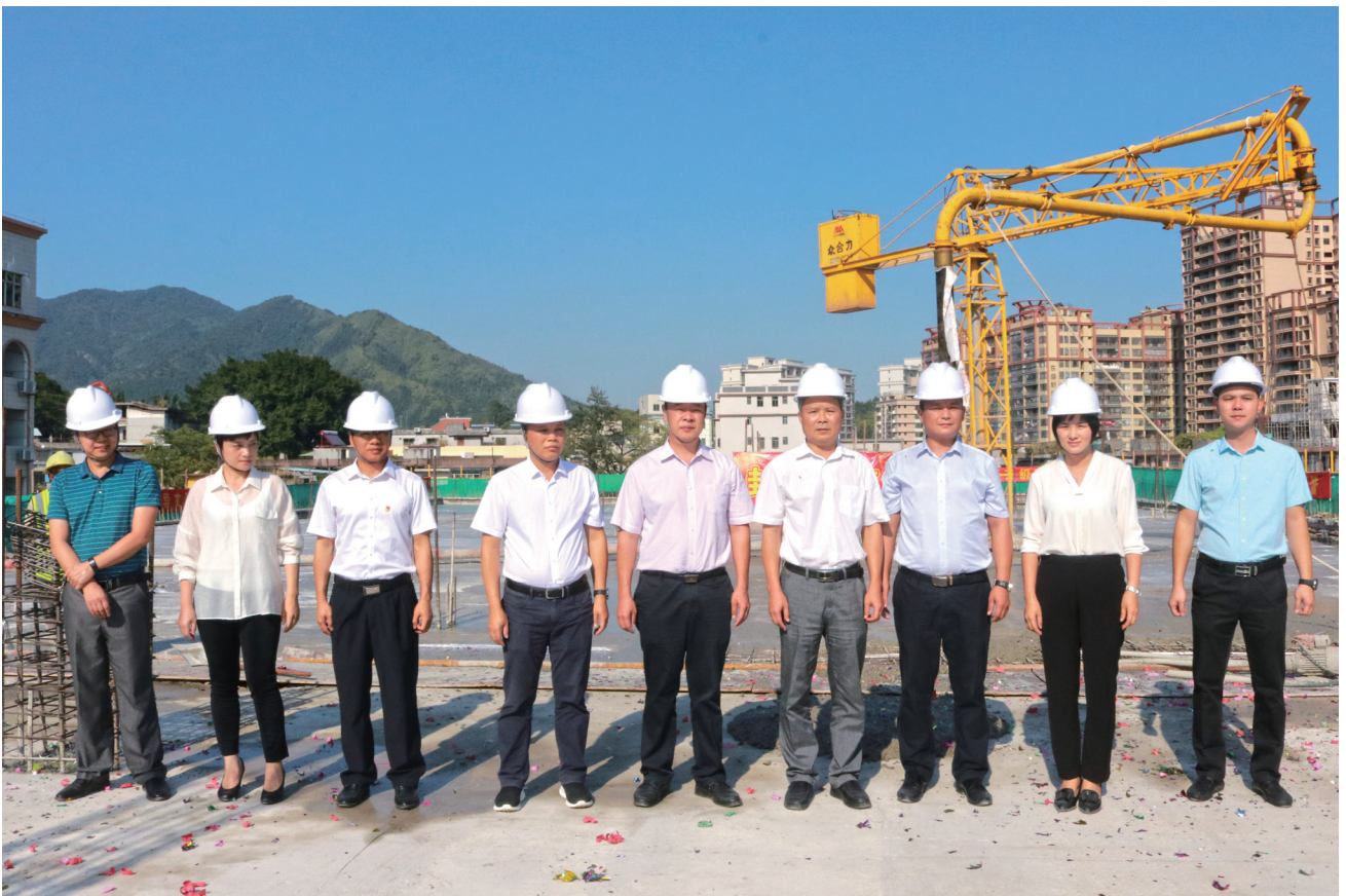
2019年9月25日，新丰县中医院异地搬迁升级建设项目门诊楼举行封顶仪式（县史志办）
